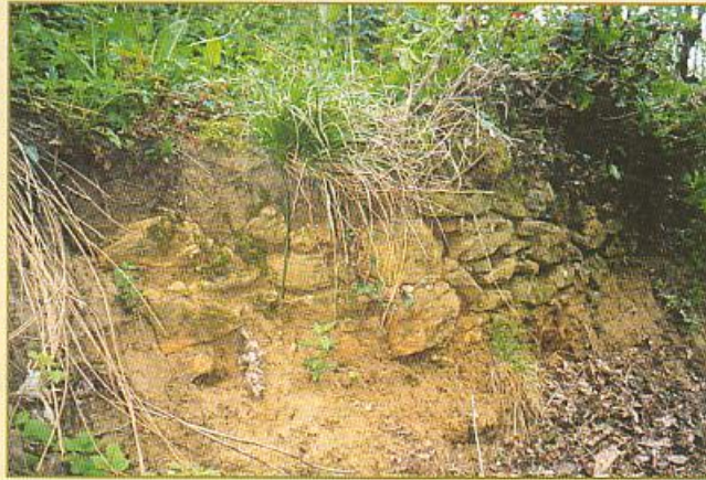
► Mur de soutènement de l'antique chemin des Rieux
